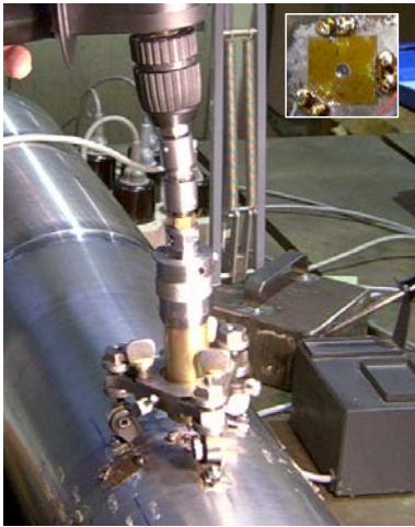
a) Odvrtání otvoru
